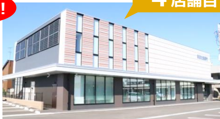
▲小千谷支店外観
