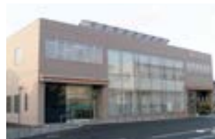
藤見町支店の太陽光発電パネル
